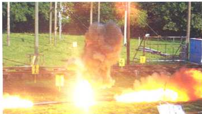
Drei Versuche vom CEF-Ausbildungstag: Die Verletzung eines Kabels z.B. durch eine Spitzhacke oder Baggerschaufel löst eine gewaltige Stichflamme aus – dies bei nur 380 V Spannung!
